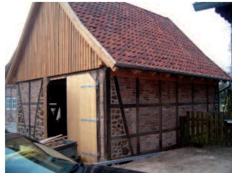
4. Die Dacheindeckung erfolgte auf einem geschaltem und regensicheren hinterlüfteten Unterdach mit den alten Tonziegeln (Handbäcker).
