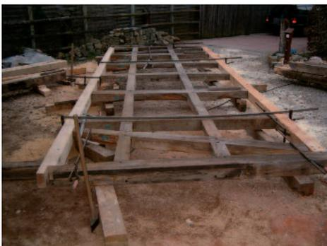
2. Nach Kennzeichnung der einzelnen Hölzer wurde der Dachstuhl und die Deckenbalkenlage vollständig entfernt.
